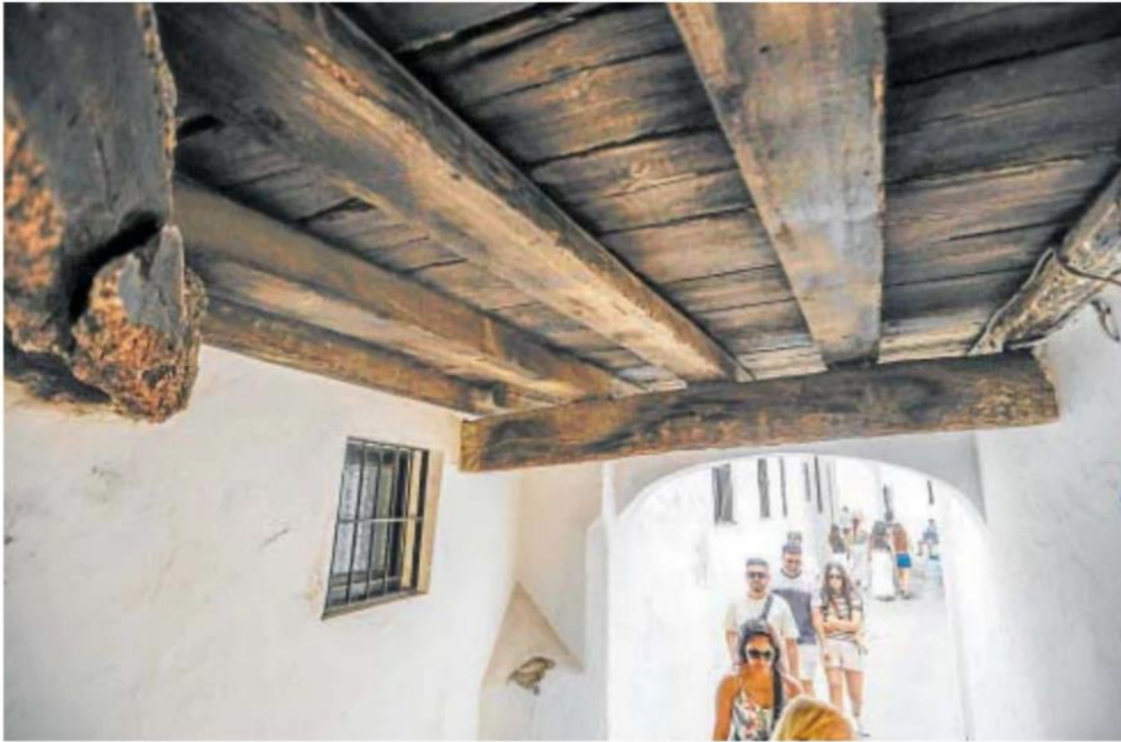
El artesanado del callejón de la Judería presenta deficiencias por la falta de mantenimiento // RAÚL DOBLADO
